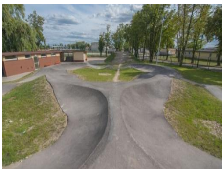
PUMPTRUCK - tor rowerowy asfaltowy
